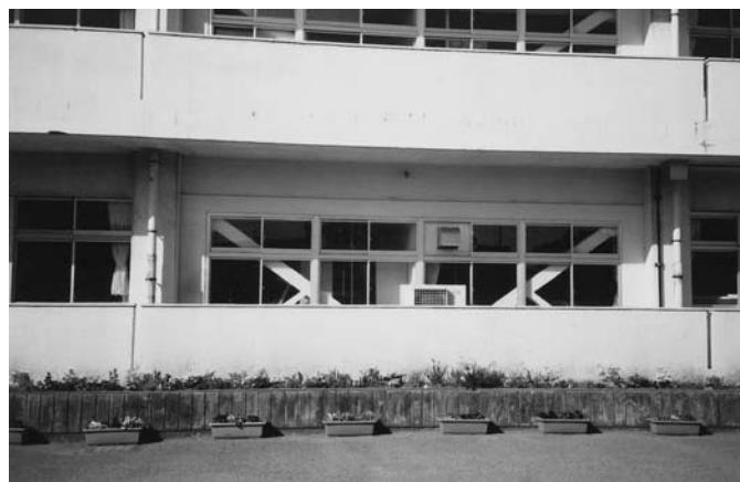
耐震補強工事完了で安全な校舎
