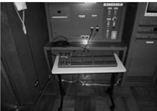
緊急的に修繕したエローラ舞台設備
