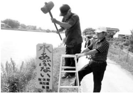
危険箇所に看板を設置しました
