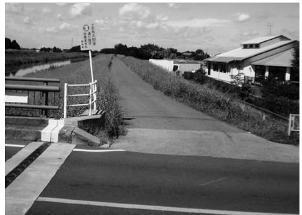
照明灯が全くない中川堤防上の道路
