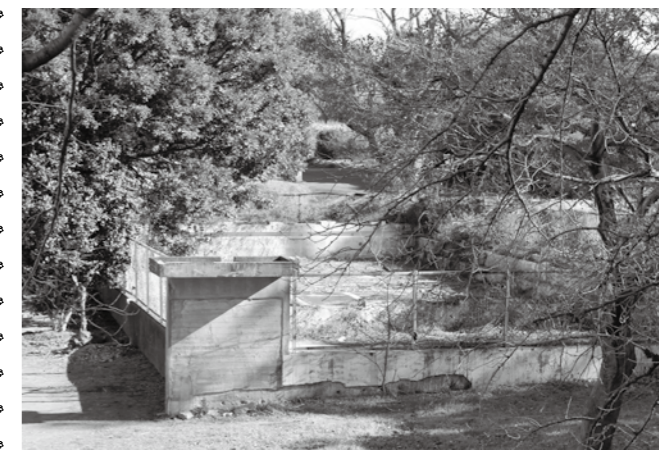
老人福祉センター前の旧町営プール
