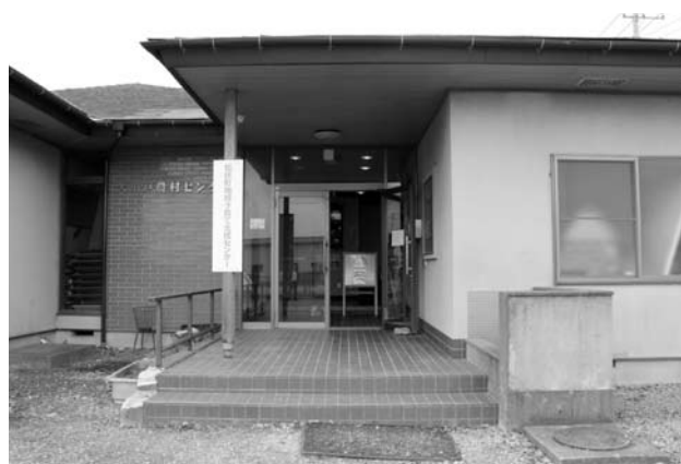
玄関にスロープがなく、室内も含めてバリアフリー化が未整備な大川戸農村センター
