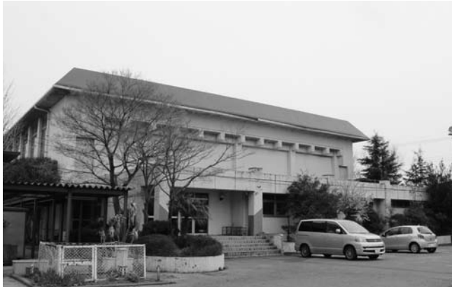
改修工事を待つ 松伏中学校体育館
