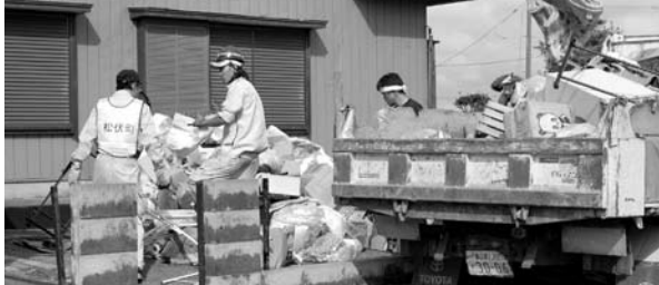
▶がれきの撤去作業
