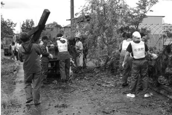
被害地のがれき処理
