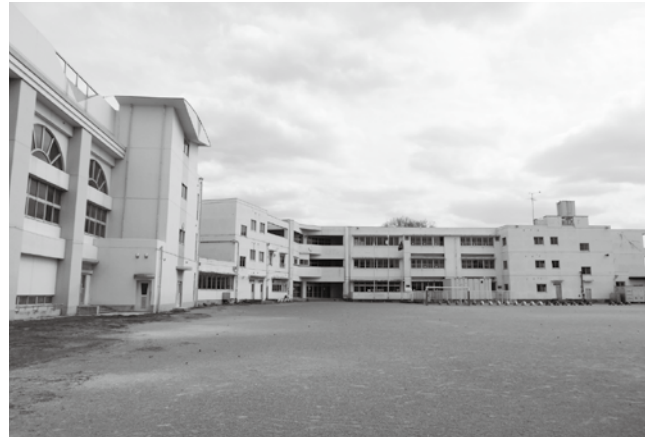
改修予定の松伏第二小学校
