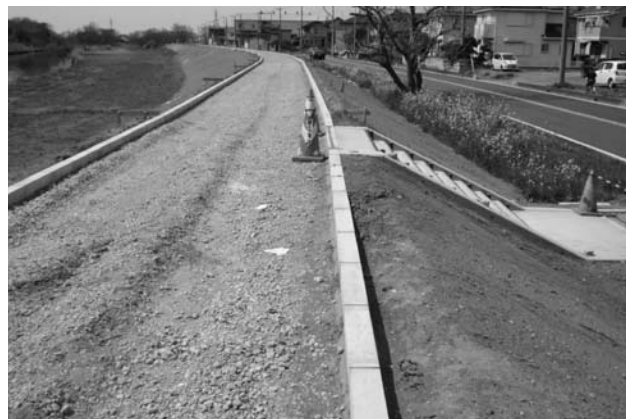
完成間近な大落古利根川沿い遊歩道 （下赤岩・弥生橋バス停付近）
