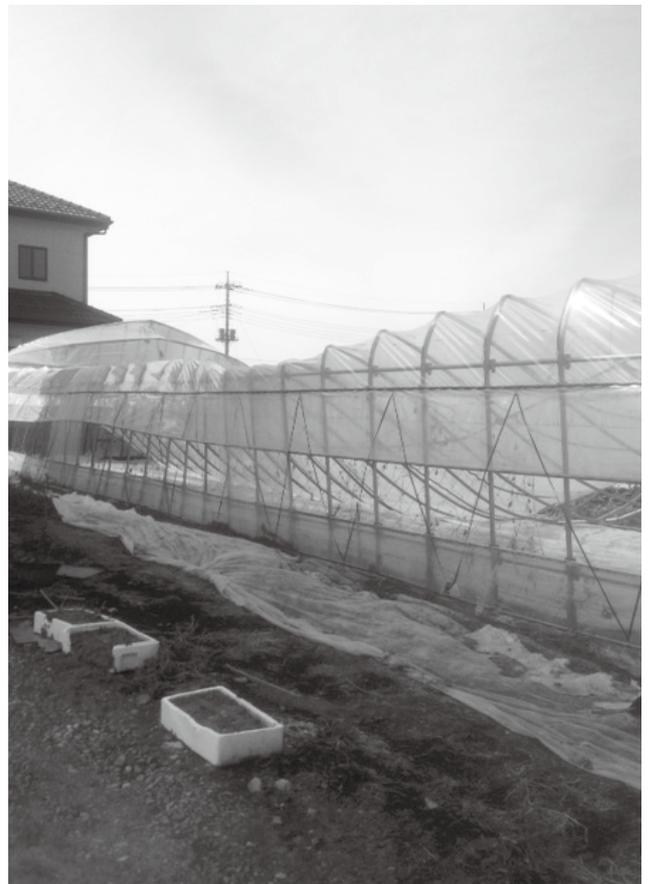
2月の大雪で倒壊したビニールハウス
