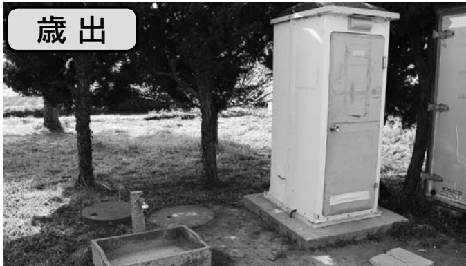
町営グラウンドの現在のトイレ
