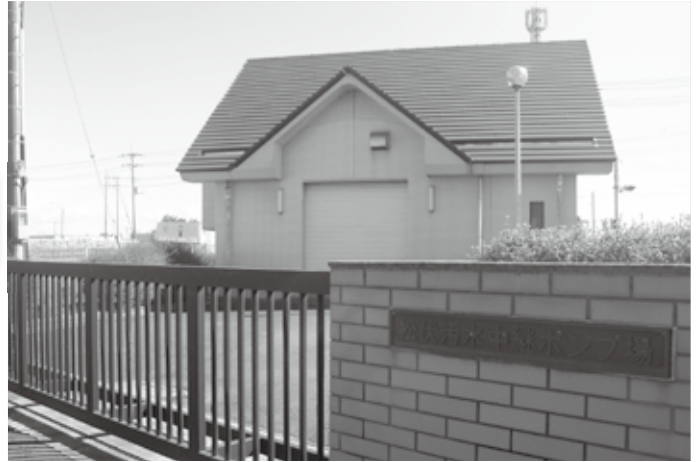
公共下水道の中継ポンプ場
