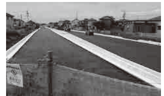
工事中の浦和野田線
