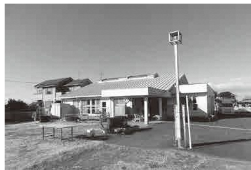
松伏町立かるがもセンター
