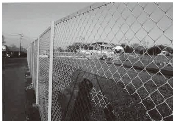
越谷市増森地内での東埼玉道路延伸工事
