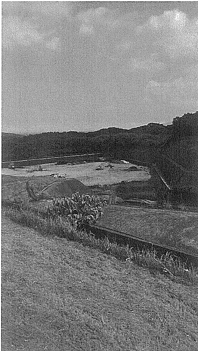
(最終処分場遠景)
