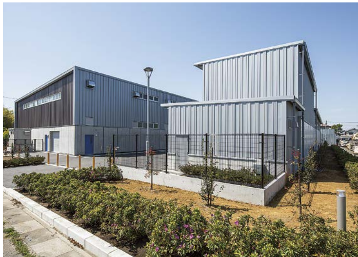
松伏町新中間処理場 (ストックヤード・工場棟外観) (令和3年9月現在)
