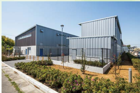
工場棟(左)とストックヤード(右)
