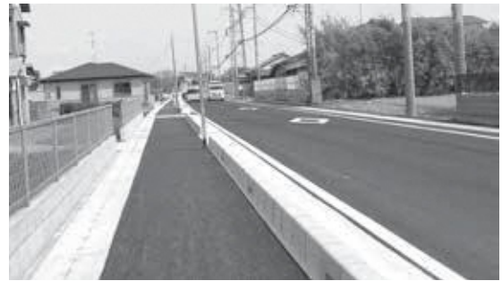
通学路の町道3号線拡幅工事では、安全性を高めるため歩車道が分離された
