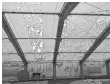
ヒョウにより被害を受けた松伏町B&G海洋センター競技用プールの屋根
