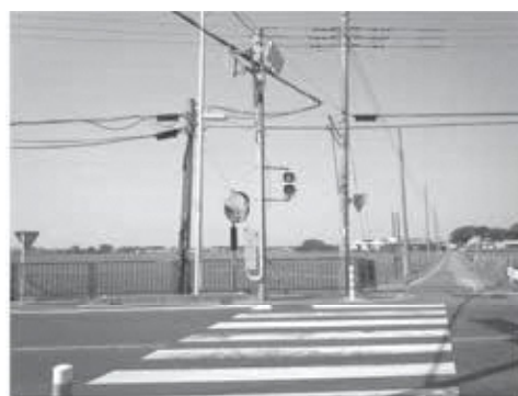
撤去対象の大川戸地区の押しボタン式信号機
