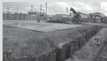
基礎工事中の保健センター 令和9年4月開所予定
