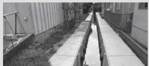
大川戸地区新々田集会所裏の 排水路整備
