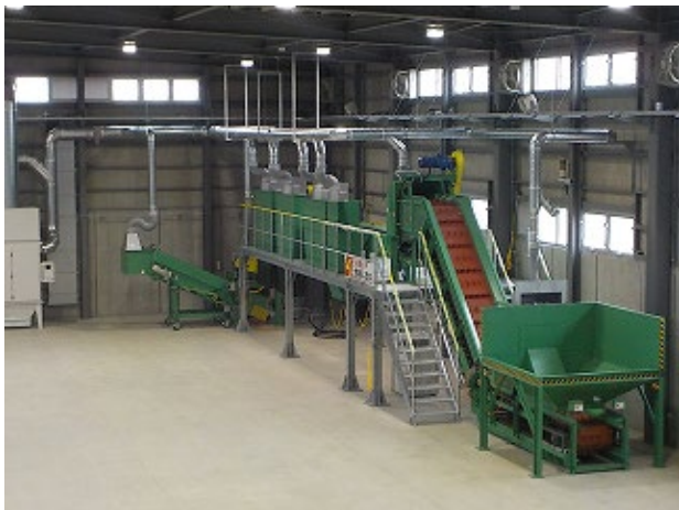
図3－5 松伏町リサイクルセンター
