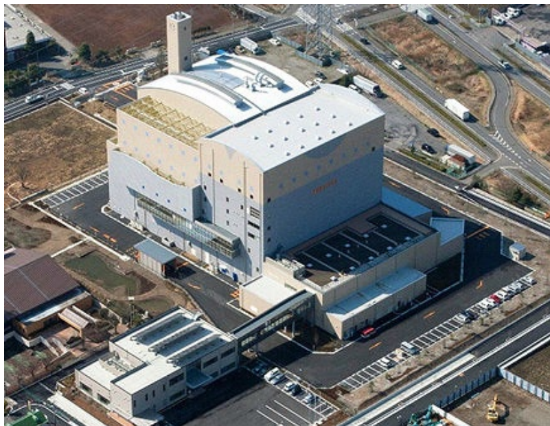
図3－4 東埼玉資源環境組合第二工場ごみ処理施設
